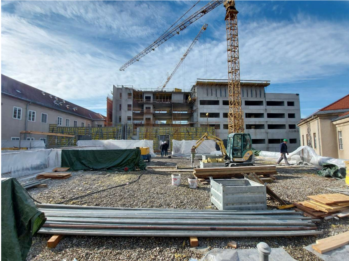
Slika 2: Aktualno stanje na gradbišču Etape 1 (januar 2021) (Izvedba Glavnega objekta, v ozadju zgrajena dozidava k UCC, v ospredju pričetek nadzidave nad UCC)
