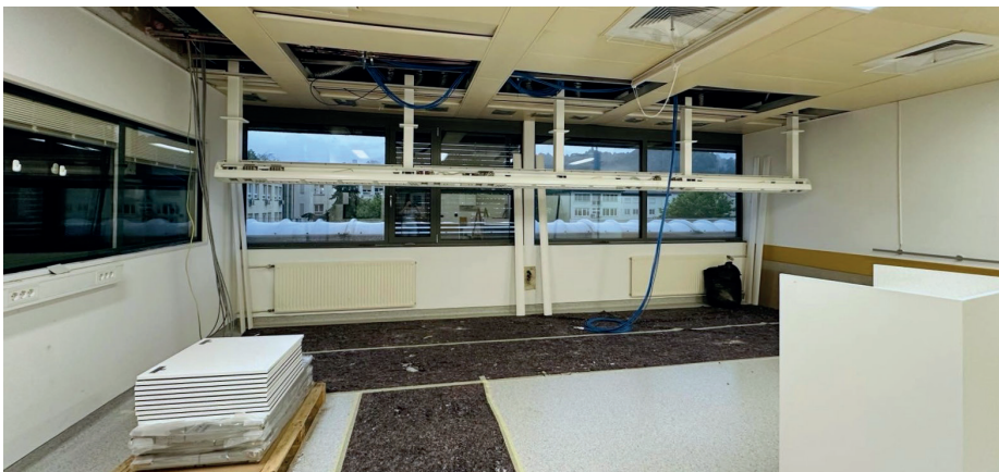
Zamenjava bolnišničnih kanalov
